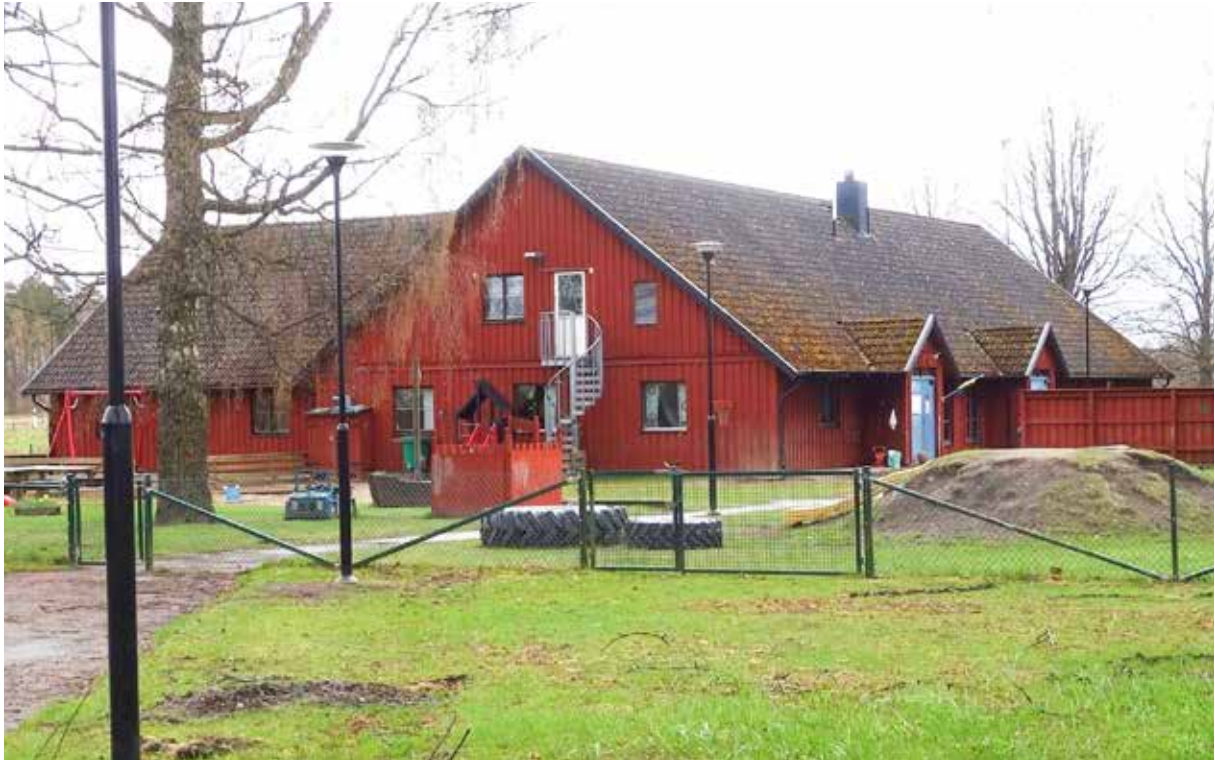
Församlingshemmet vid Skönberga kyrka är en modern byggnad vars utformning anspelar på ladugårdens för att passa in i den kulturbistoriska miljön. Servicebyggnaderna kan utformas på ett liknande sätt.
