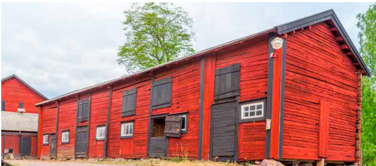
Foto på knuttimrad ladugård. De svarta knutskåpen delar in byggnaden på ett radhusliknande sätt.
