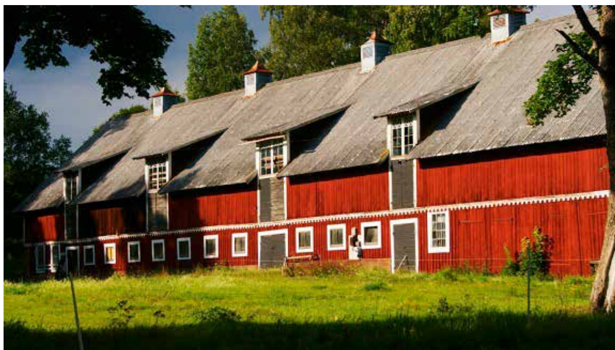
Foto ladugård i Åfors. Den långa ladugården med många dörrar kan användas som historisk inspiration vid byggande av radhus. Källa http://nicke-grozdanovski.blogspot.com
